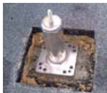
StandOff einsetzen
