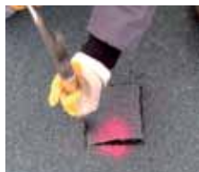
Öffnen der Dachhaut
